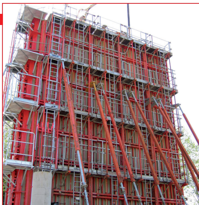
Chantier : Ligne LGV Est
