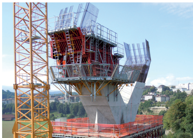
Une utilisation des banches TPC standard pour un ouvrage d'exception (Pont de la Poça à Fribourg - Suisse)
