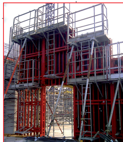
Chantier : Stade de Nice
